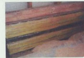
底盤を拡大する工法ではないので、基礎の沈下を止めるすることはできません。
